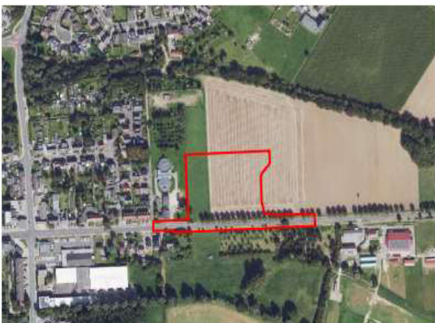
Abbildung 2: Luftbild mit Plangebiet
