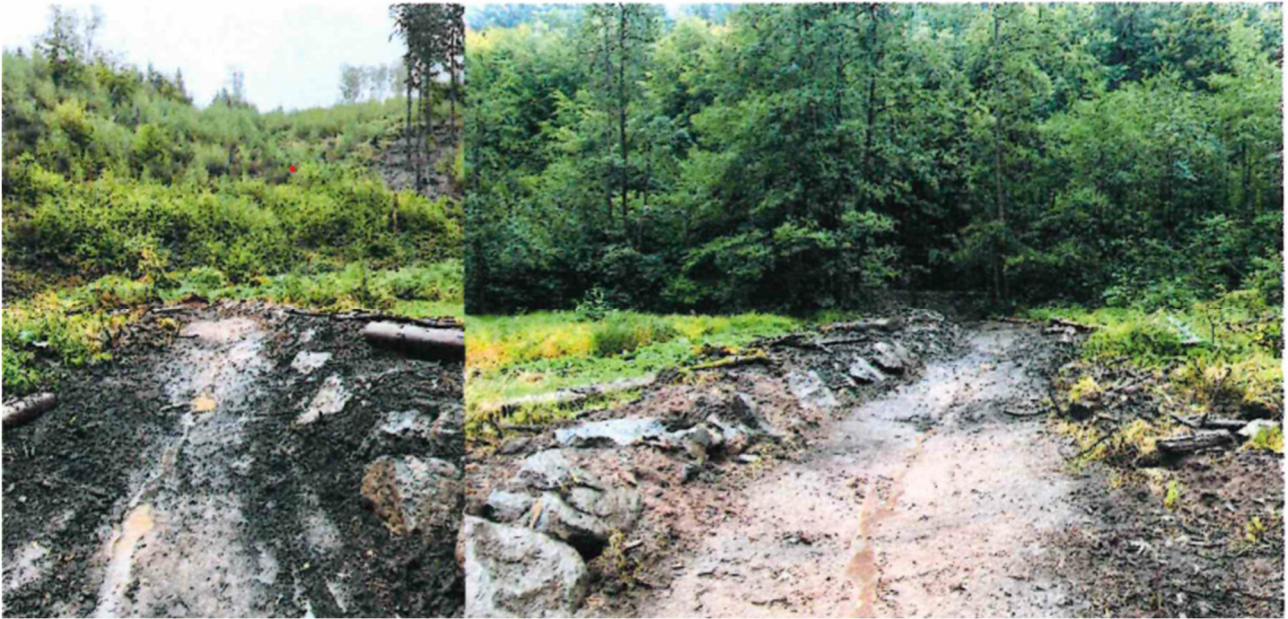
Abbildung 3: Fertig umgesetzte Stützungsmaßnahme mit Wasserbausteinen und Grabenherstellung als Ableitgerinne
