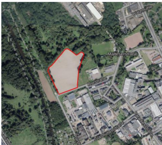
Abbildung 1: Plangebiet im aktuellen Luftbild (2023)
