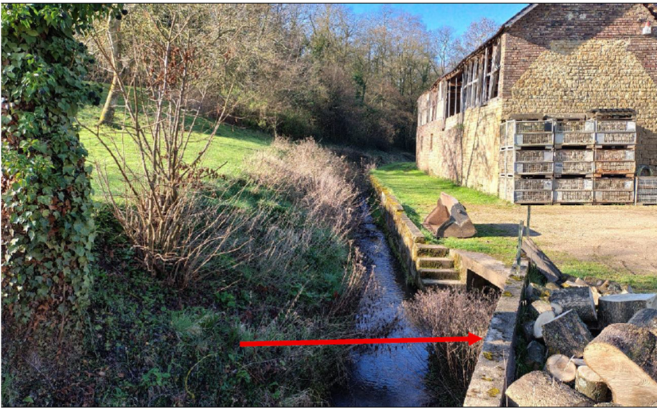
Abbildung 3: Blick von der Brücke auf den befestigten Neffelbach mit der ungefähren Stelle für die temporäre Ersatzbrücke.
