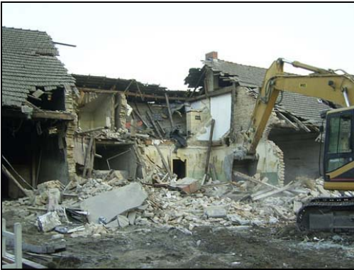
Die Schädlichkeit der anfallenden Abfälle muss vor dem Abbruch geprüft werden.
