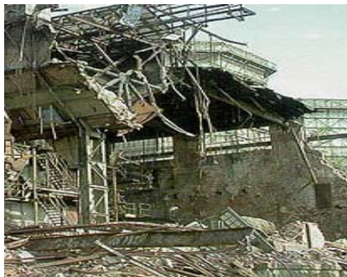
Beim Abbruch ehemaliger Industrieanlagen fallen massenweise recycelfähige Abfälle an.
