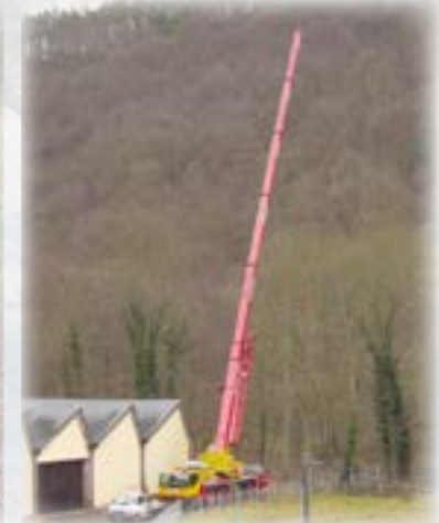
Es gibt viele Lösungen, aber keine von der Stange – Sondereinsatz eines Krans zur Fällung einer großen Pappel
