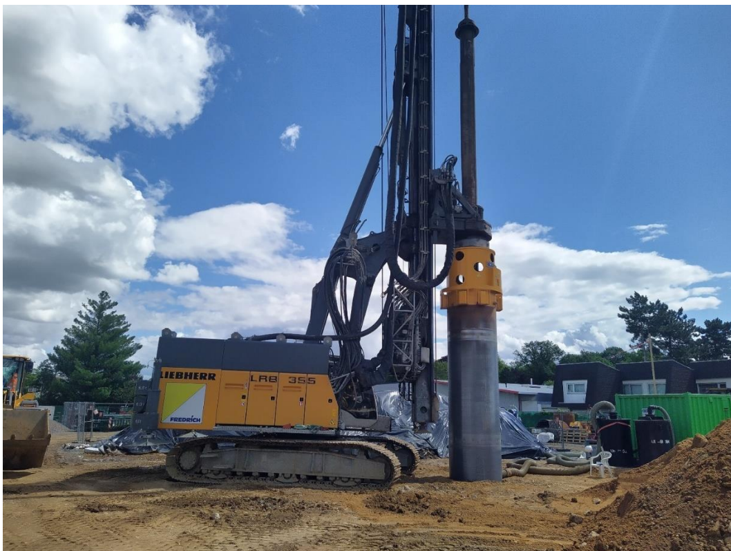
Abbildung 11: Großlochbohrungen zur Sanierung der Bodenbelastungen
