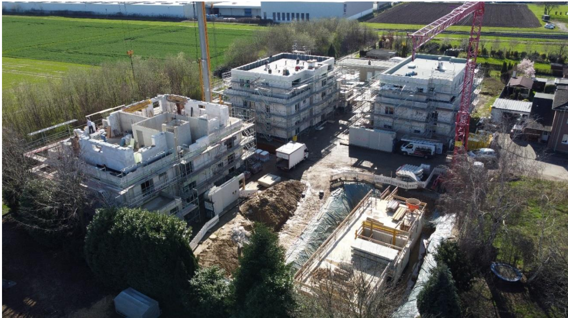
Abbildung 1: Bauvorhaben Zehnthofstraße in Huchem-Stammel
